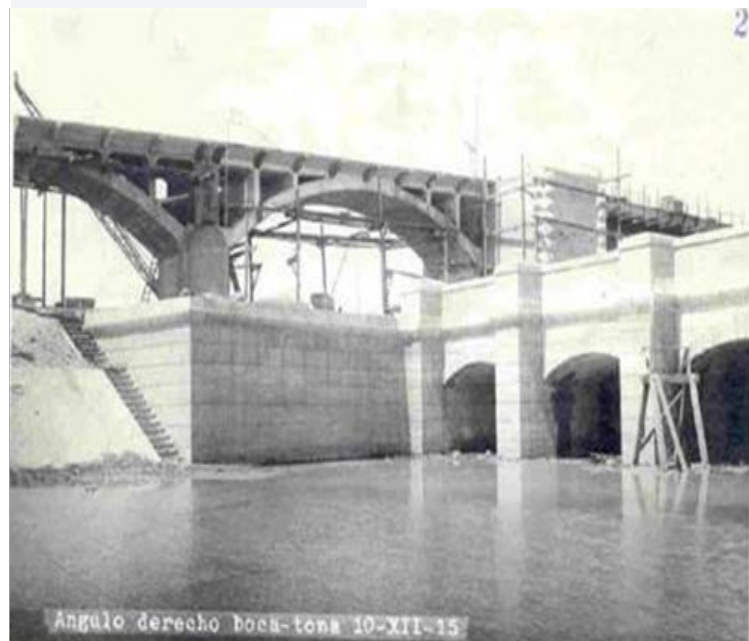
Figura 33: Boca toma del canal Fuente: Museo del Agua - Barda del Medio - Río Negro
