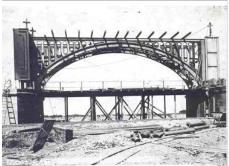
Figura 34: primer tramo del puente 1914 Fuente: Museo del Agua Barda del Medio – Río Negro
