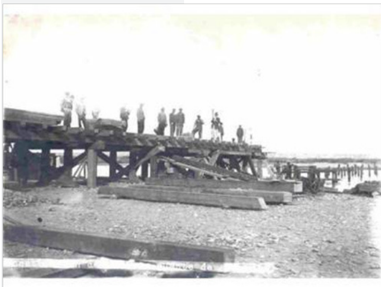
Figura 31: Construcción del primer puente en quebracho - 1910 Fuente: Museo del Agua – Barda del Medio – Río Negro
