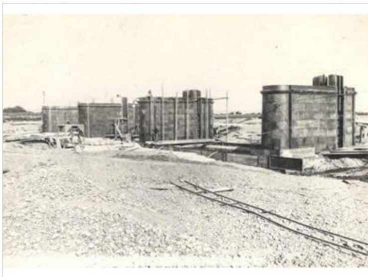
Figura 32: Canales del segundo desvío a la platea - 1913
