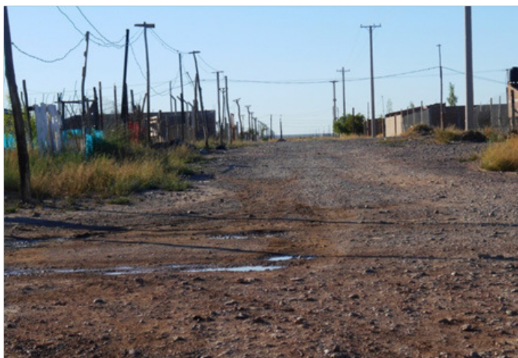
Figura 14: Falta de arbolado en las calles de la Segunda meseta Foto: Alejandro Tambussi
