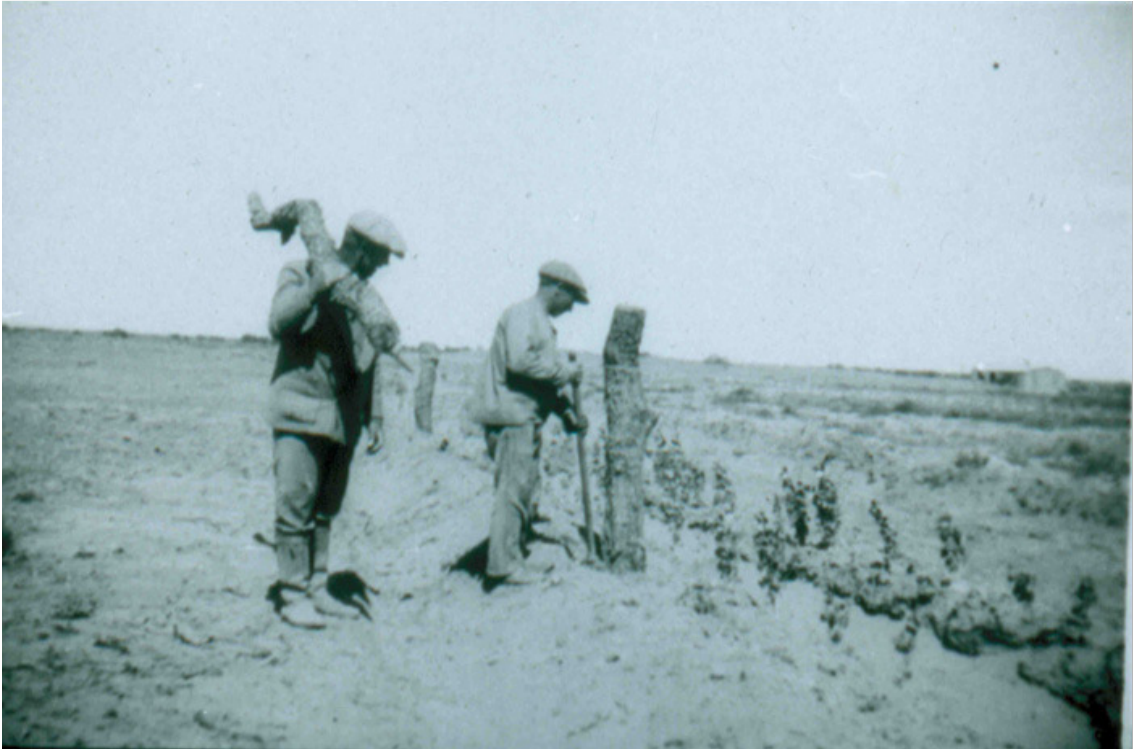
Figura 39: primeros trabajos en lo que serían las chacras
